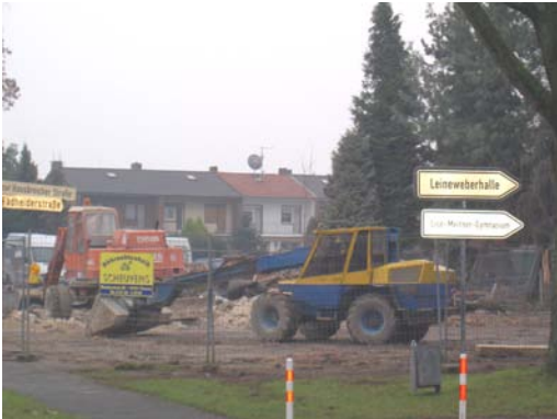
Abriss der Turnhalle Dezember 2008
