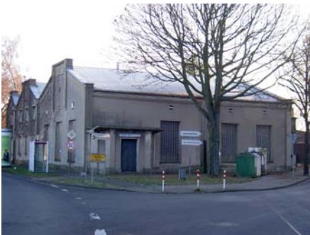
Turnhalle Schottelstraße im Dezember 2007
